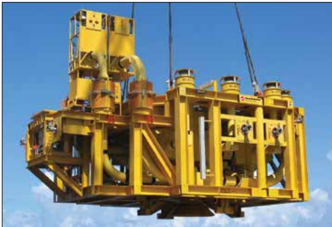
Figura 1. Colector submarino. Este colector, que está siendo levantado para ser instalado en el fondo marino, tomará los fluidos producidos en varios pozos y los llevará hasta una línea de flujo que se conecta a una plataforma de producción.
