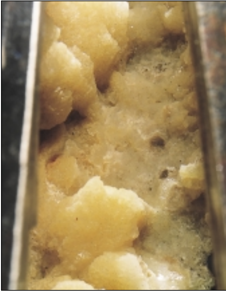
▲ Eliminación de incrustaciones de carbonato de calcio con chorros de agua. La tubería de producción recibió un solo chorro de agua a razón de 2,4 pulg./min [1 mm/seg]. Si bien se ha logrado remover los sedimentos de carbonatos, todavía se observa una cantidad remanente considerable.
